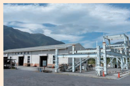
機械実習棟・鉄骨躯体教材 クレーン運転や玉掛け、鉄骨躯体の組立・解体などを行う。
